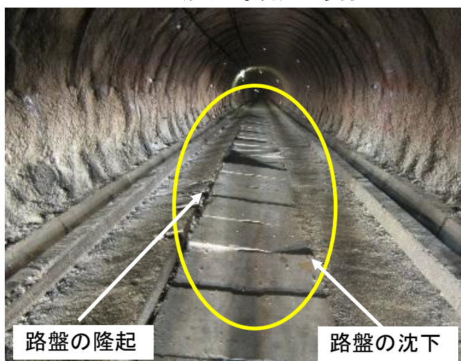
トンネル（先進導坑）の変状
