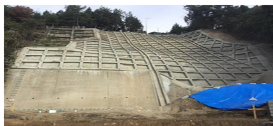
コンクリート枠による斜面の補強
