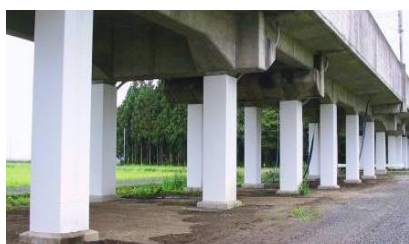
鋼板巻きによる高架橋の耐震対策
