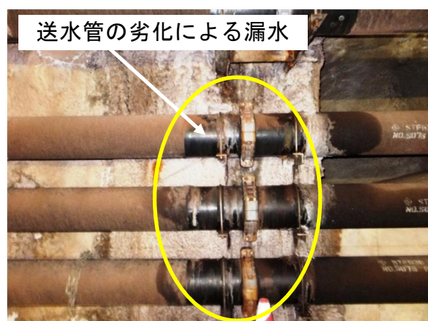
消火施設への送水管の劣化
