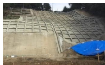
斜面の補強
