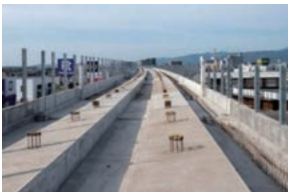
福井高柳高架橋
