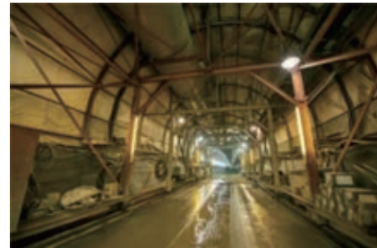
新北陸トンネル(大桐工区)
