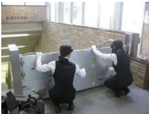
写真8 止水設置訓練
