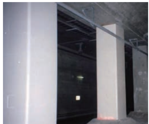
写真1 耐震補強後の中柱
