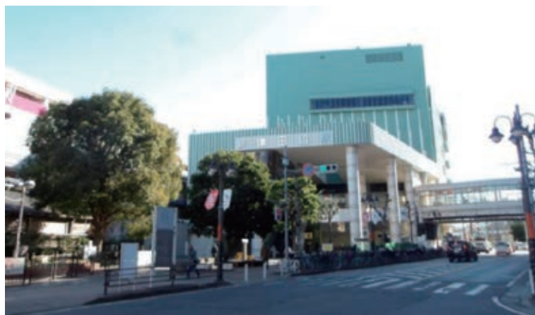
イオンモール津田沼 South 外観（2026年1月撮影）
