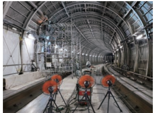
南北線シェルター耐震改修工事の様子
