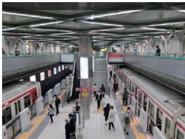
千里中央駅（地下1階通路部から撮影）
