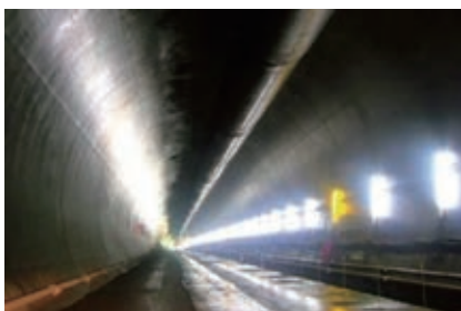
三本木原トンネル
