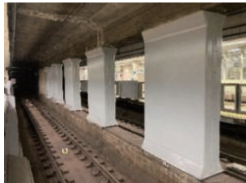
地下部の耐震補強
