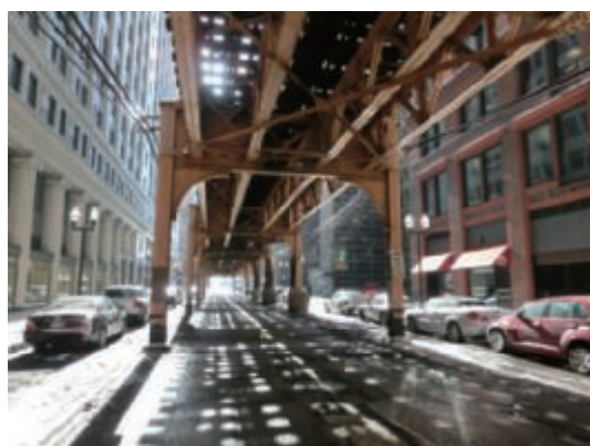
写真－２ 通称L(エル)と呼ばれる高架鉄道の鋼製高架橋。線路下の道路も通行可能である。(2014年1月19日)
