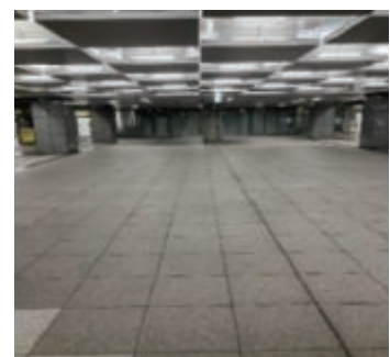
LED化された駅構内
