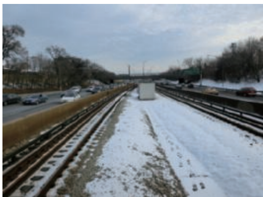
写真－１ 鉄道と道路を同時に建設すれば、用地も一緒に確保でき、また鉄道を地平で建設することが可能なので、事業費が各段に安くなる。CTAのBlue Lineの両側をKennedy ケネディー高速道路が走る。(都心方を見る。2014年1月19日)
