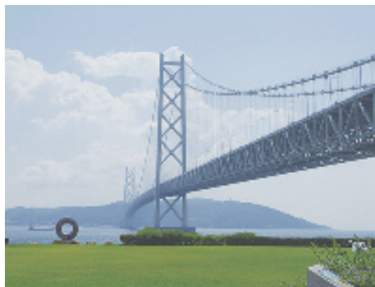
明石海峡大橋
