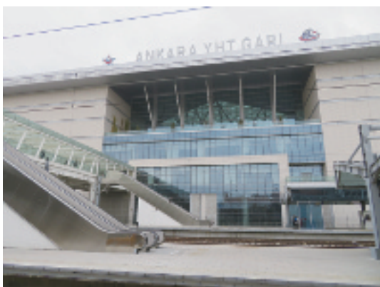
写真-84 アンカラ駅の南側に2016年に開業したYHT専用のATG駅舎。手前は在来線のホーム。(南西を見る。2020年2月3日)
