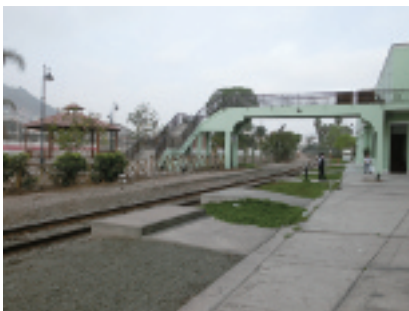
写真-4 デサンパルドス駅のホームと単線線路(軌間1435mm)。現在は貨物列車が主体であるが、山岳地帯までの観光列車も運行される。(東を見る。2015年11月20日)
