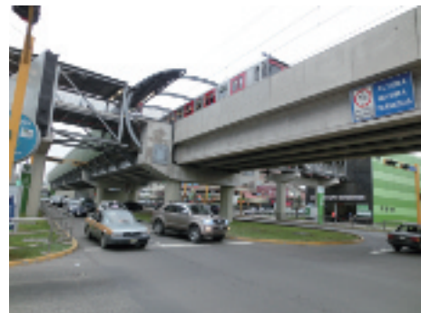
写真-6 アビアシオン通りの中央分離帯部分に建設されたメトロ1号線とサン=ボルハ=スル駅。(2015年11月20日)
