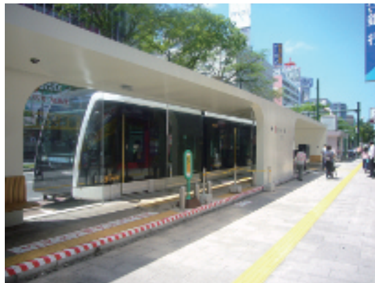
<サイドリザーベーション方式で整備された狸小路停留場>
