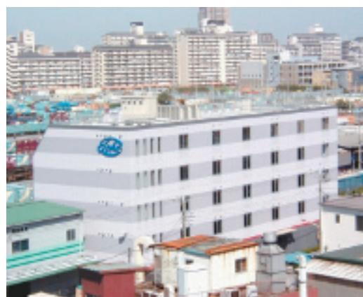
写真-2：隅田川ビル
