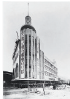
図-④ 神戸駅（現在の神戸三宮駅）のターミナルビル
