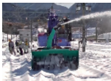
マルチ軌道除雪機による除雪状況
