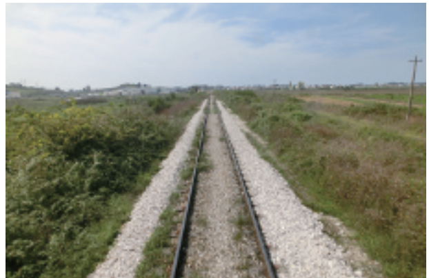
写真-35 ドゥラス～ヴォーラ間は単線。両脇にバラストは入っているが、軌道整備は行なわれていない。(ドゥラス方を見る。2014年9月18日)
