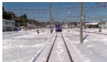
除雪でレールが完全に露出
