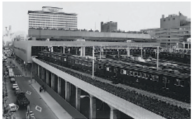
図一⑥ 梅田駅拡張第4期工事竣工
