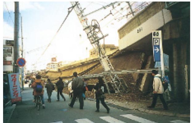
図一⑨ 倒壊した西宮北口～夙川間高架橋
