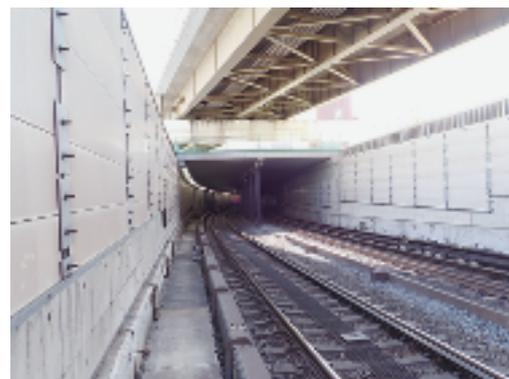
写真3 U型トンネルのコンクリートボックス化
